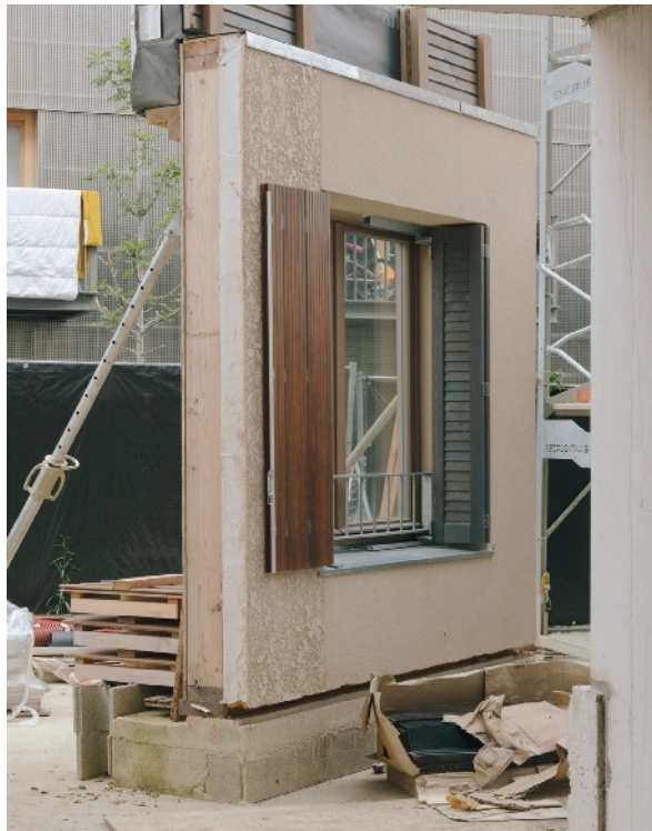
Les façades ont intégré dès l'usine le maximum d'éléments, dans l'optique d'optimiser les temps de chantier. LA Architectures
