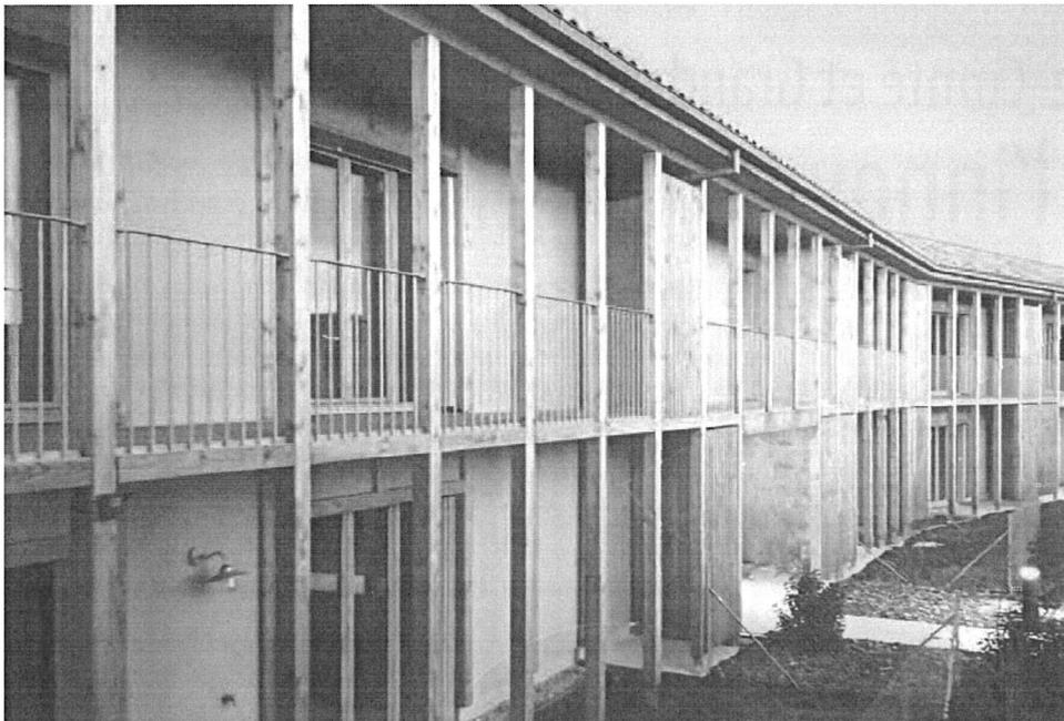
du Haut-Doubs, qui a lancé la construction d'un bâtiment exemplaire de 650 m<sup>2</sup>. La structure en ossature bois et lamellé-collé utilisera pour partie des épicéas locaux touchés par les scolytes. Le chantier de cette recyclerie intégrera le réemploi de matériaux issus de chantiers de déconstruction, de chutes ou d'erreurs de commandes et du recyclage de mâchefers d'incinération.
