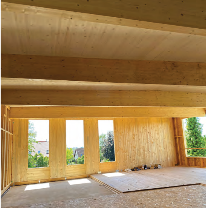
Traitement sur site dans une maison des services : ignifugation via vernis intumescent de 196 m 2 de panneaux CLT de plafond. (Crédit photo : Fibex)
